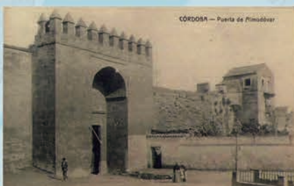
Estado de la Puerta de Almodóvar y su entorno inmediato en la década de 1920 (GARCÍA VERDUGO, M., 1994)
