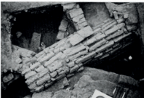
Detalle de la construcción abovedada interceptada por la calzada
